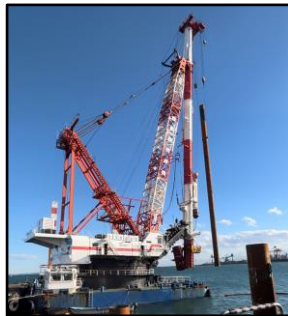
【本体杭打設(杭打設船)】
