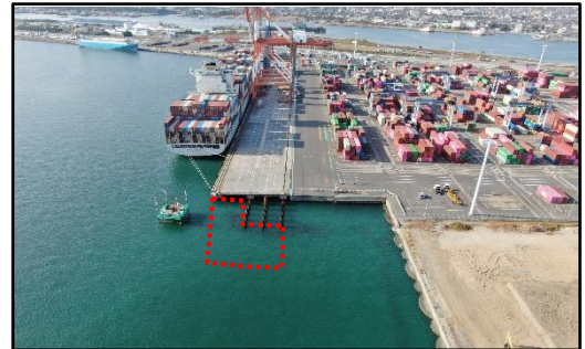
【本体杭打設(R5d打設範囲)】
