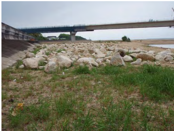
工事用地撤去後の状況(春季)左岸上流側より撮影
