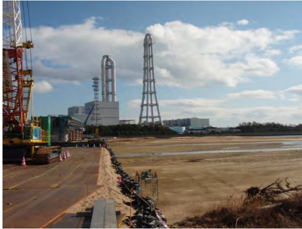
工事による砂の凸部(冬季)左岸工事区域上流端より撮影
