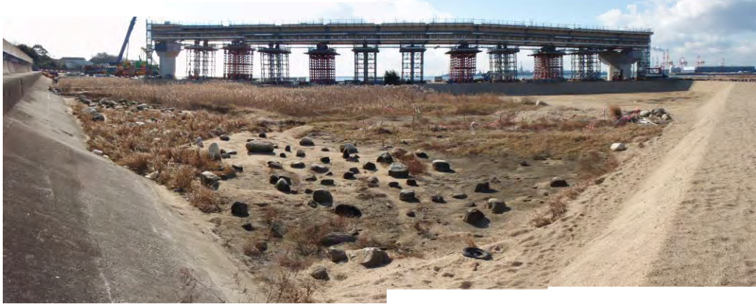
河口左岸(上流より)
