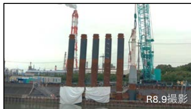
鋼管矢板打設状況
