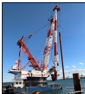
【本体杭打設(杭打設船)】
