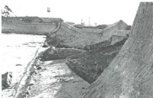
石原地区堤防の決壊 (伊勢湾台風による被害写真) 出典：四日市港のあゆみ(昭和62年3月発行)
