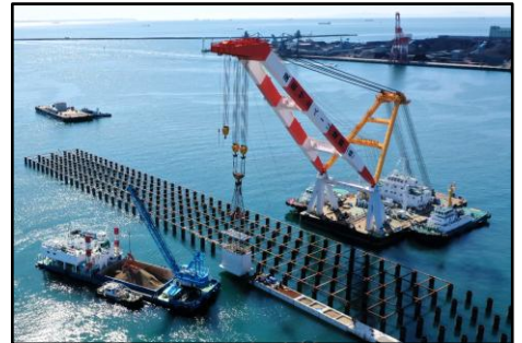
【土留本体据付工事(ケーソン据付)の様子】
