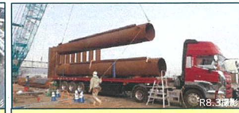
鋼管矢板(上杭)搬入状況
