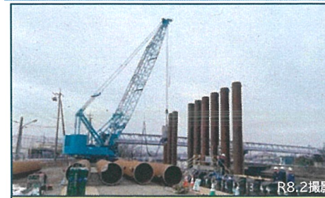
鋼管矢板(下杭)打設状況①(振動工法)
