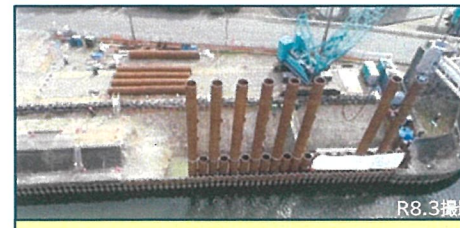
鋼管矢板(中杭)打設前状況
