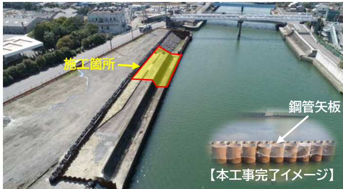
護岸工事箇所
