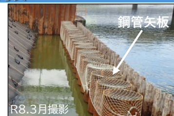
鋼管矢板(近景)
