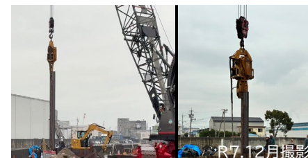
仮設鋼矢板打設状況(パイプロハンマによる打設)
