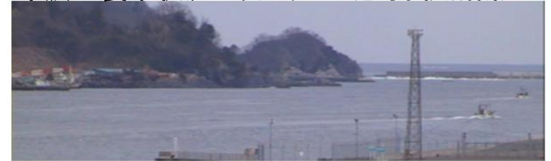
地震発生26分後：津波第1波がケーソン目地から流入
