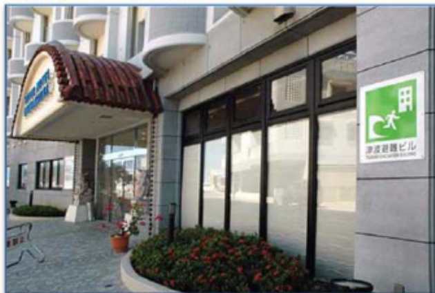
津波避難ビルの指定を受けているホテル(石垣市) 出典:石垣市HP
