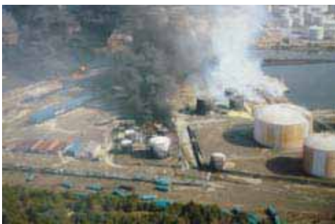
仙台製油所における火災発生状況
