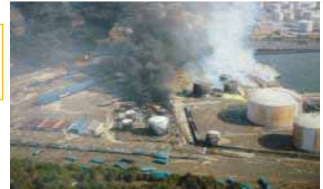
仙台塩釜港: 仙台製油所で発生した火災
