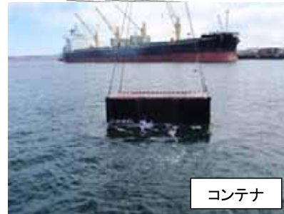
■障害物の引き揚げ作業
