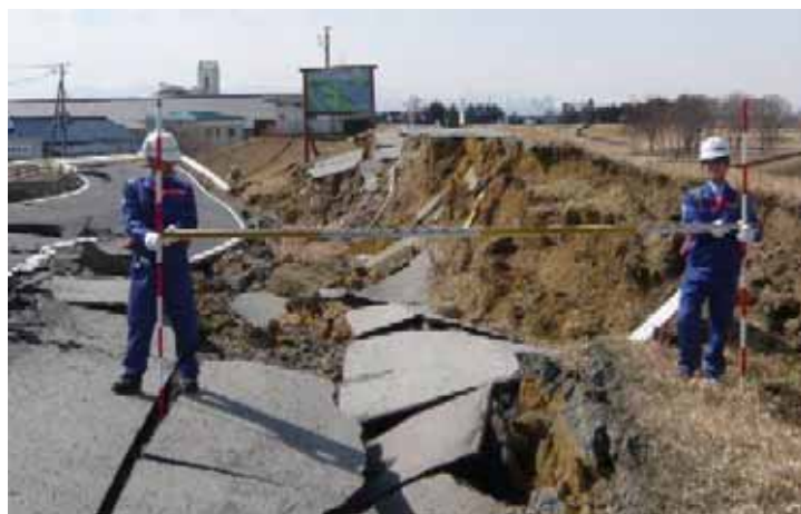
鳴瀬川中流部(30.1K付近)において堤防が崩落 〈写真右側が鳴瀬川、手前が下流〉(宮城県大崎市)
