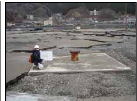
須賀地区ふ頭のアスファルト舗装版が広範囲にわたり被災(中央部は岸壁の係船柱)
