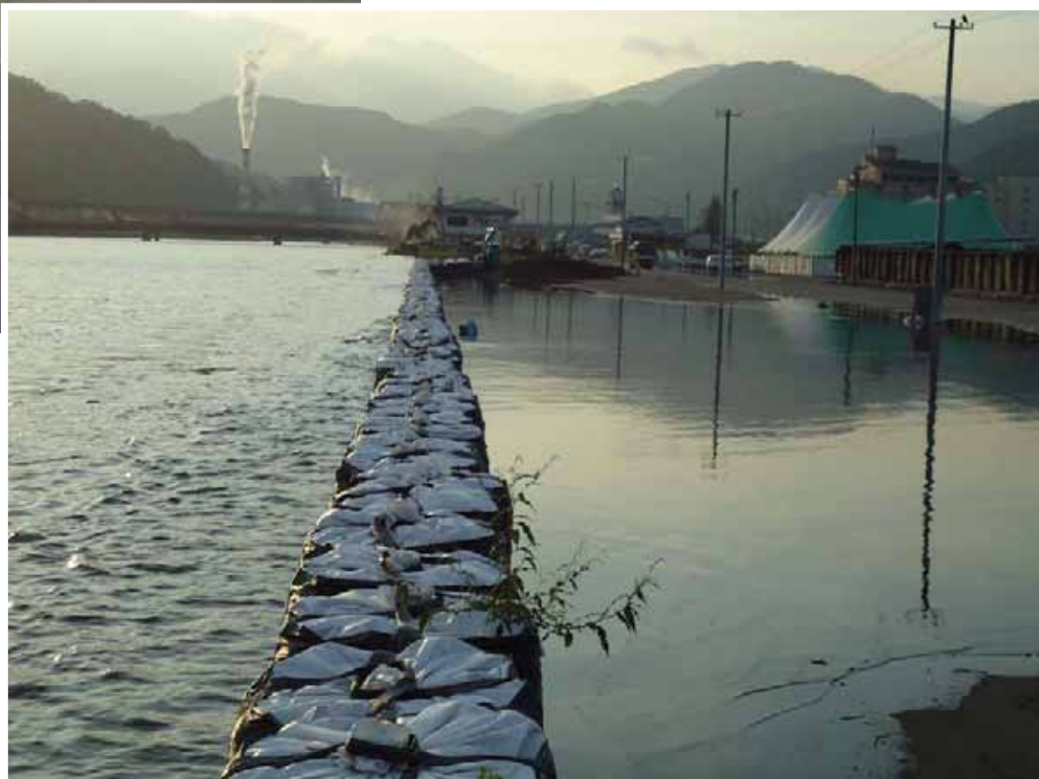
釜石港 須賀地区(満潮時)
