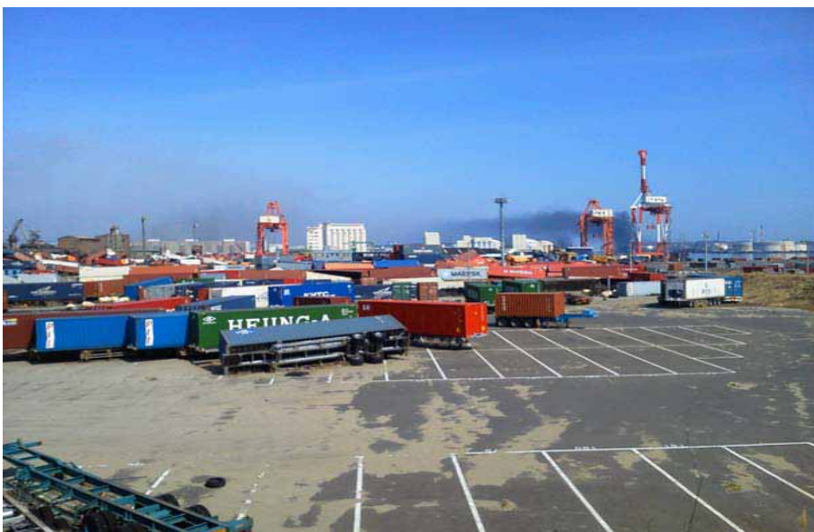
高砂コンテナターミナル岸壁(-14m)の背後ヤードのコンテナ散乱
