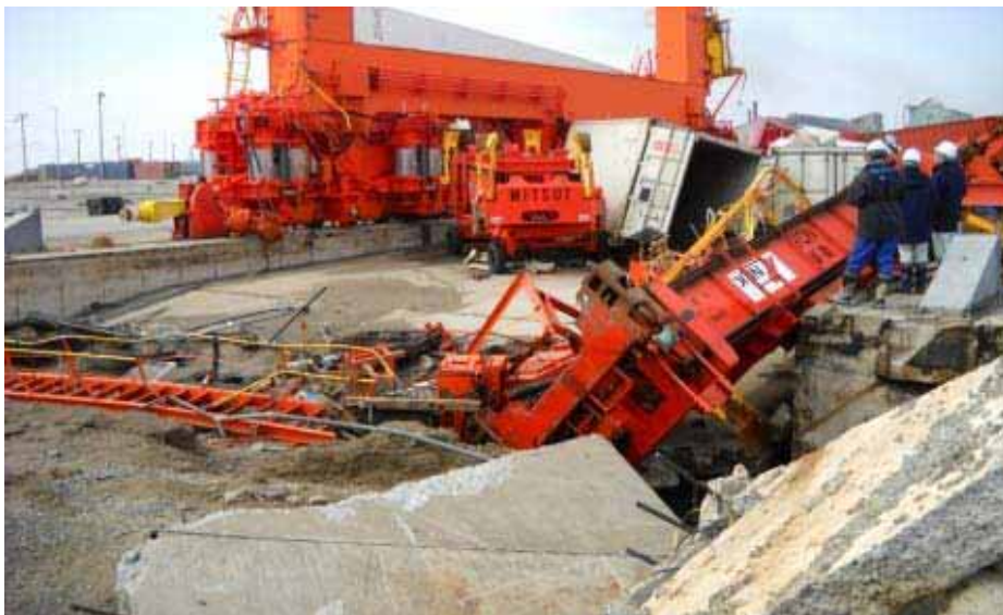
仙台塩釜港 高砂コンテナターミナル岸壁(-14m)の荷役機械の損壊
