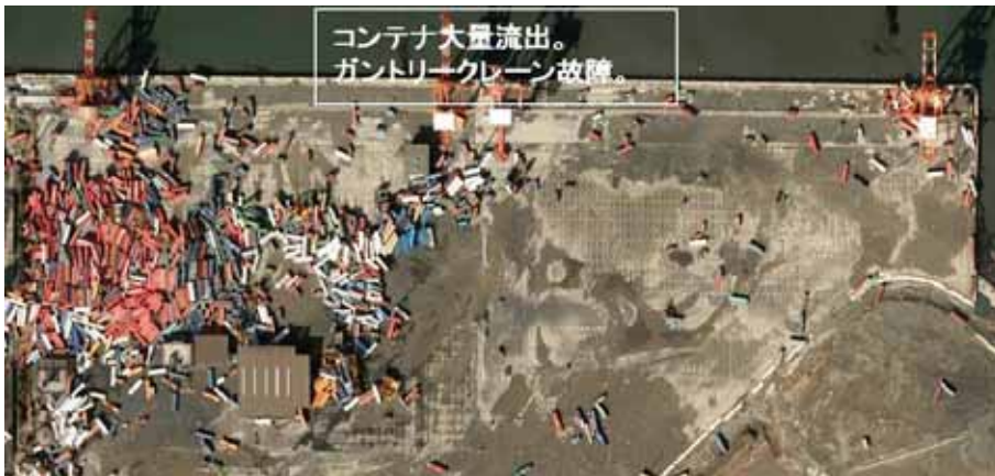
仙台塩釜港 仙台港区 高砂埠頭のコンテナ散乱状況
