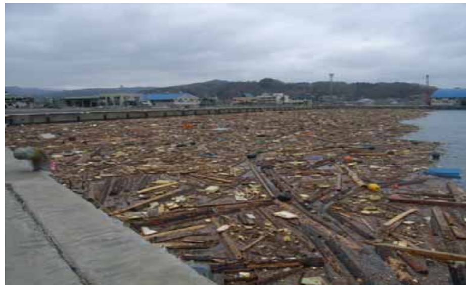
宮古港 藤原地区 岸壁前面を埋め尽くすガレキ
