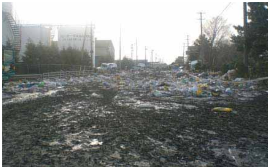
石巻港 釜地区 臨港道路釜北線 瓦礫により通行不能
