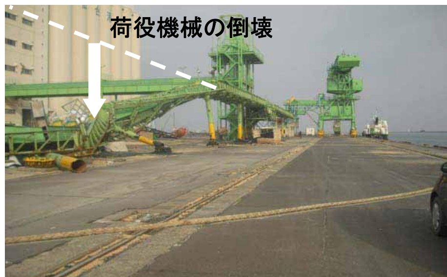
仙台塩釜港 中野地区 1号岸壁(-12m)背後 荷役機械の倒壊
