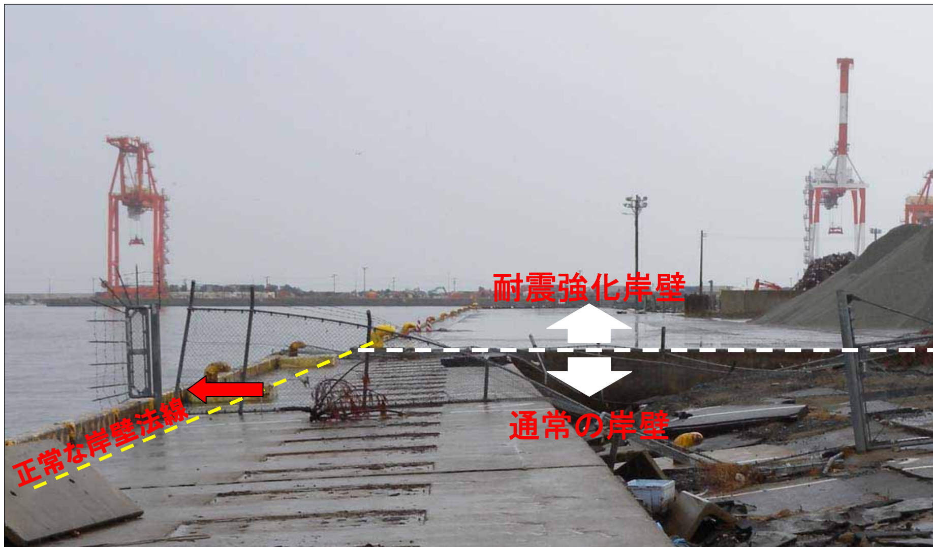
■耐震強化岸壁（仙台塩釜港 仙台港区）の事例
