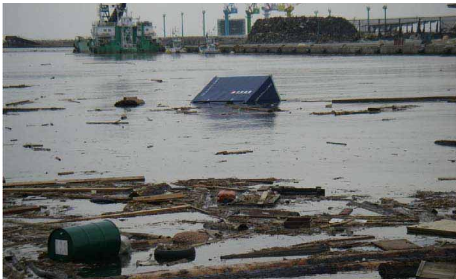
石巻港 釜地区 中央水路 漂流物による航路埋塞
