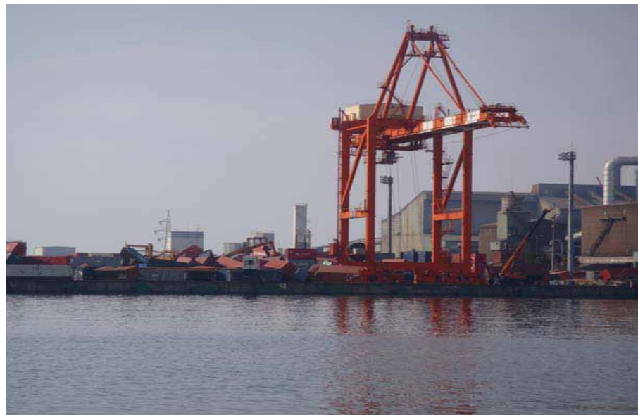
高砂コンテナターミナル岸壁(-14m)のコンテナ散乱
