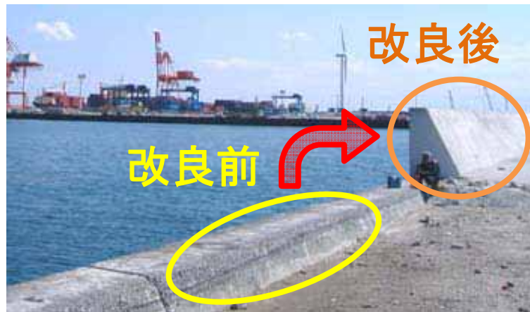
既設護岸・防潮堤の改良（嵩上げ）
