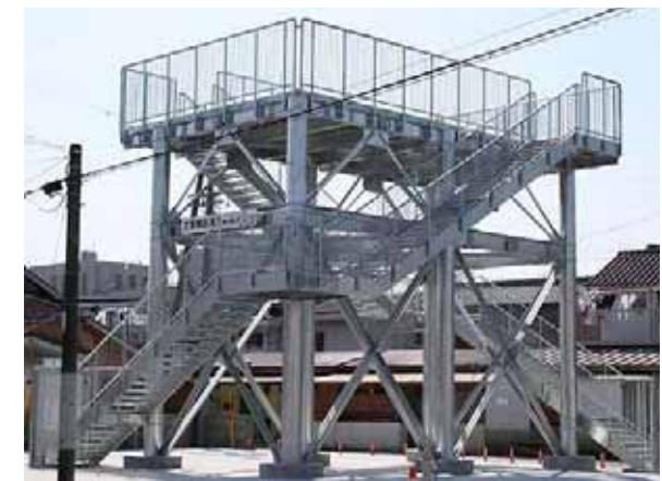
津波避難施設の設置
