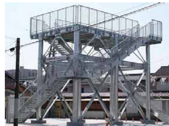
津波避難施設の設置
