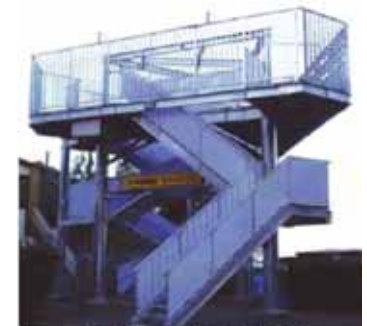
避難用タワー整備の例(沼津市)
