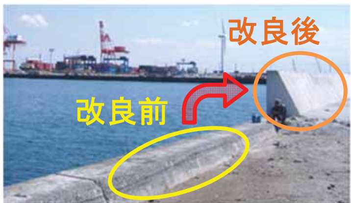
既設護岸・防潮堤の改良(嵩上げ)
