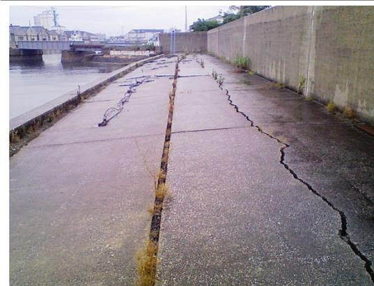
内部土砂流出によるエプロン陥没状況
