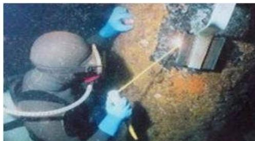
▲ 水中溶接による電気防食の施工
