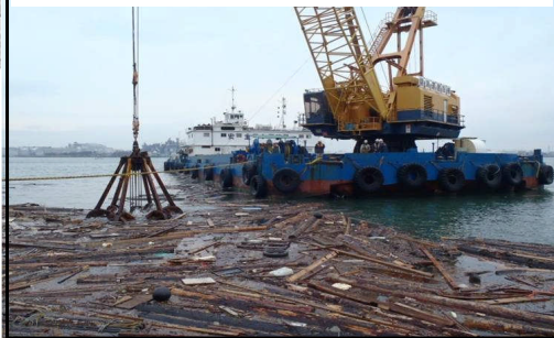
【航路啓開の様子(石巻港)】
