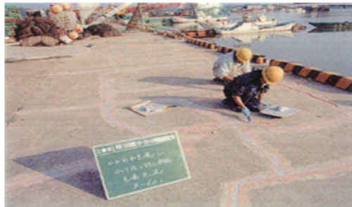
▲ エプロンのひび割れに樹脂を充填
