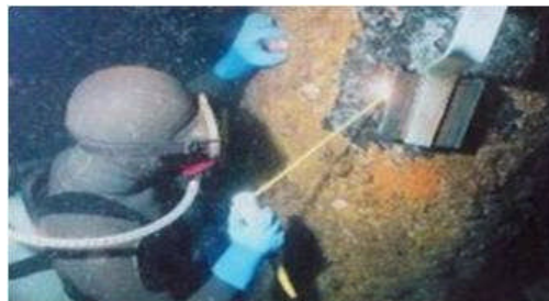
▲ 水中溶接による電気防食の施工
