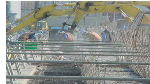
▲ 床版の打ち替え
