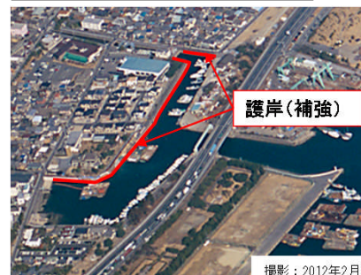
富田港地区 護岸(補強)
