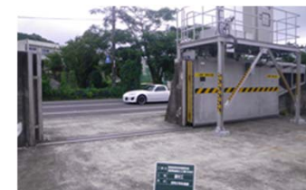
自動化・電動化されている陸閘の例
