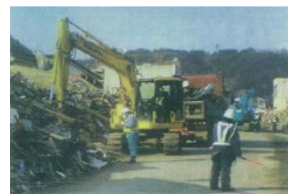
道路啓開の事例 国道45号（岩手県宮古市）
