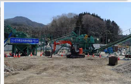
東日本大震災 約2年後 コンクリートがらの再生処理の例
