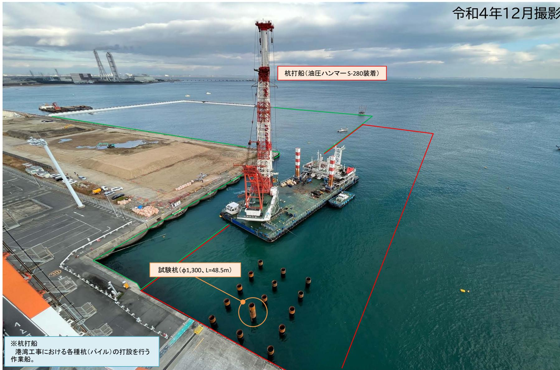
岸壁工事では、杭の打設から養生(約2ヵ月)後に支持力確認のため、試験杭で急速载荷試験を行います。
