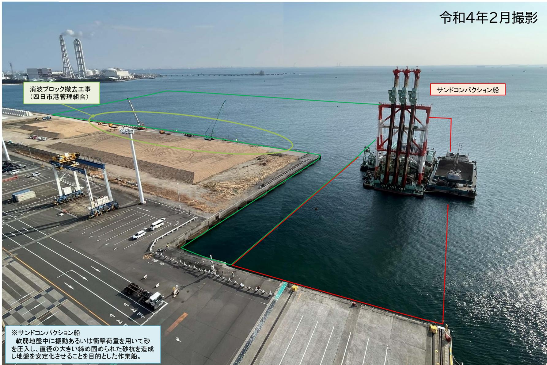
岸壁工事では、鈴鹿川より運搬してきた砂を地盤改良材として使用を始めました。
