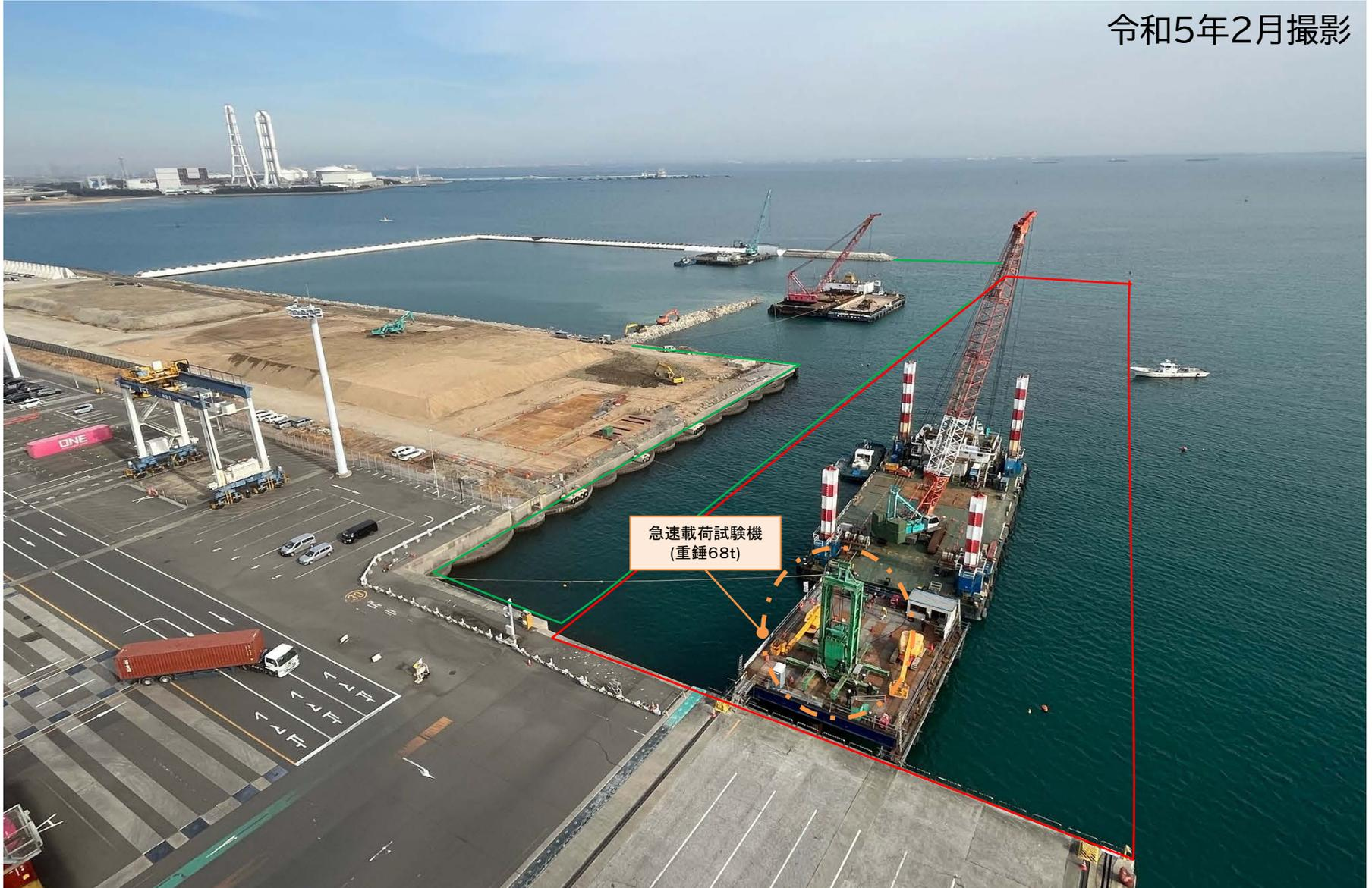
基礎石を投入する範囲において、堆積中の土砂を掘る「床掘工」を実施しています。浚渫した土砂は、岸壁背後の埋立地にバージアンローダ船を用いて投入し、埋立材として再利用しています。
