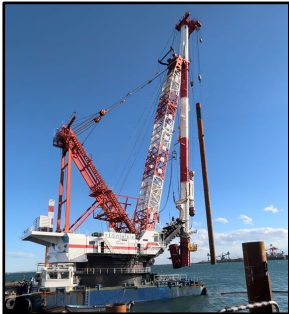
【本体杭打設(杭打設船)】
